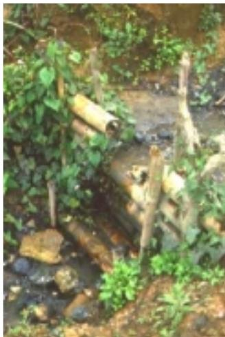
**Figura 12.** Trincho vivo con amortiguador conformado por piedra y guadua para recibir en forma disipada aguas provenientes del vertedero.
