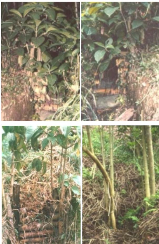
**Figura 14.** Trinchos vivos de guadua (*Guadua angustifolia*) y estacas de quebrabarrigo (*Trichanthera gigantea*) donde finalmente el entrecruce de raíces de las estacas vivas se transforman en disipadores naturales de las aguas de escorrentía.
