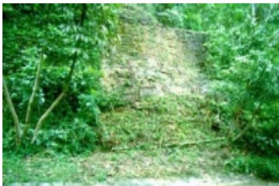
**Figura 9.** Trinchos vivos para conducir aguas de escorrentía en derrumbes superficiales
