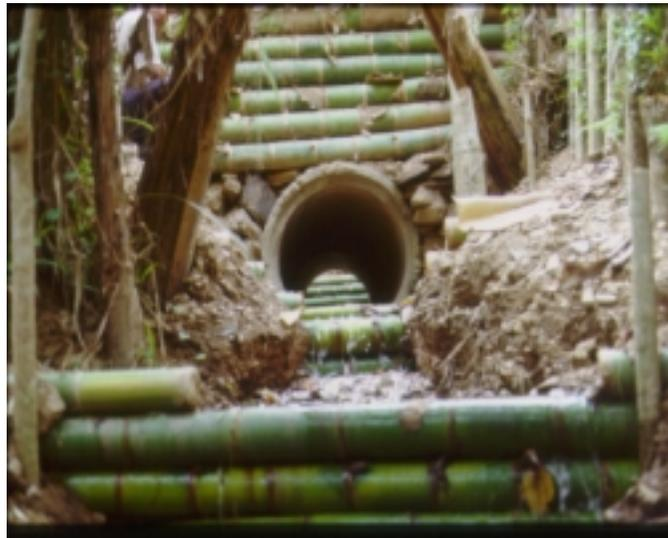
**Figura 3. Empotramiento de tubería para conducir las aguas de la quebrada por debajo de la banca de la carretera. Se observan trinchos vivos escalonados a ambos extremos de la tubería. Febrero 19 de 2003.**
