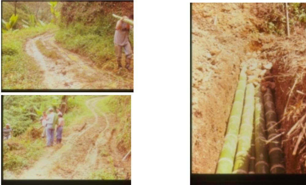
**Figura 4. Construcción de filtros vivos atravesando banca de carretera para su drenaje. Noviembre 8 de 2002.**
