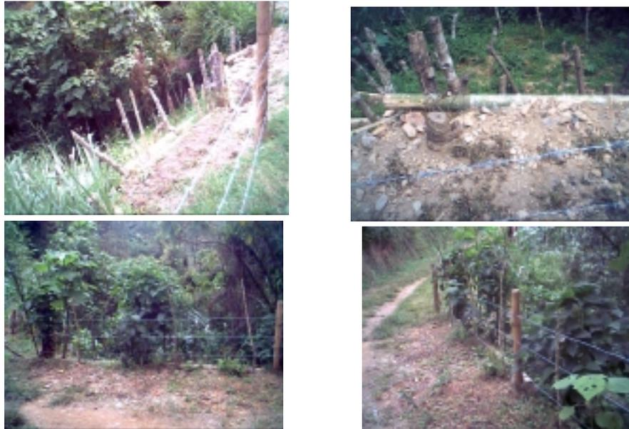
**Figura 6. Proceso de recuperación de banca de carretera, mediante terrazas en tierra escalonadas. Vereda Villa Rosa, Argelia Valle. Septiembre 19 de 2003.**
