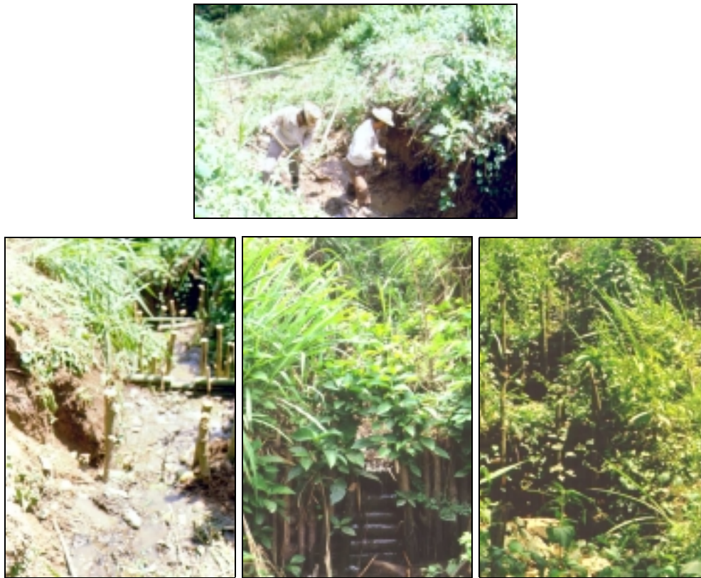
Figura 5. Secuencia de recuperación de una quebrada erosionada en su cauce y taludes laterales (Granja Rafael Escobar, Supía, Caldas).
