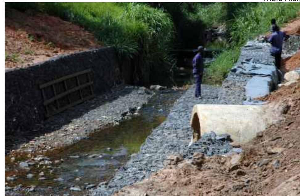
Obras no Córrego dos Patos: os "gabiões" evitam deslizamentos de terra.
