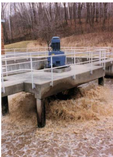
Figura 3: Laguna con oxigenación por aireadores superficiales.
