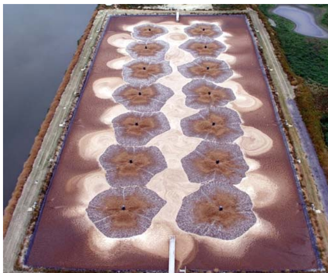
Figura 3: Laguna con oxigenación por aireadores superficiales.
