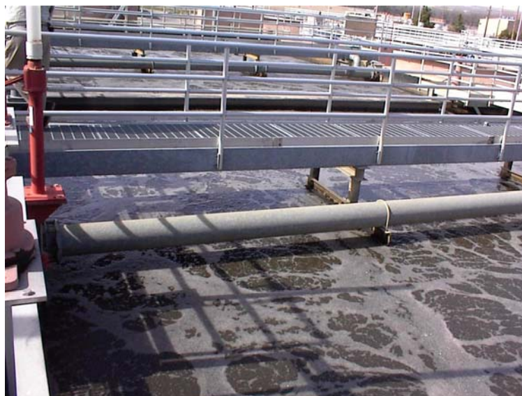
Figura 8: Digestor aerobio con aireación por difusores sumergidos.
