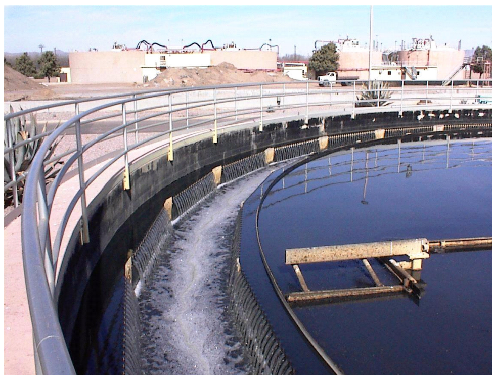
Figura 6: Sedimentador circular con alimentación al centro y colector periférico, en el cual se observan las canaletas o colectores que reciben el efluente de agua clarificada para enviarlo a la siguiente etapa de tratamiento
