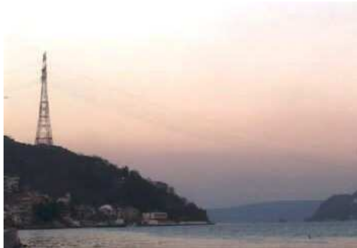
Resim 7-Boğaz atlama elektrik iletim hattı
