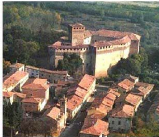
Montechiarugolo - Vista aerea del borgo medievale
