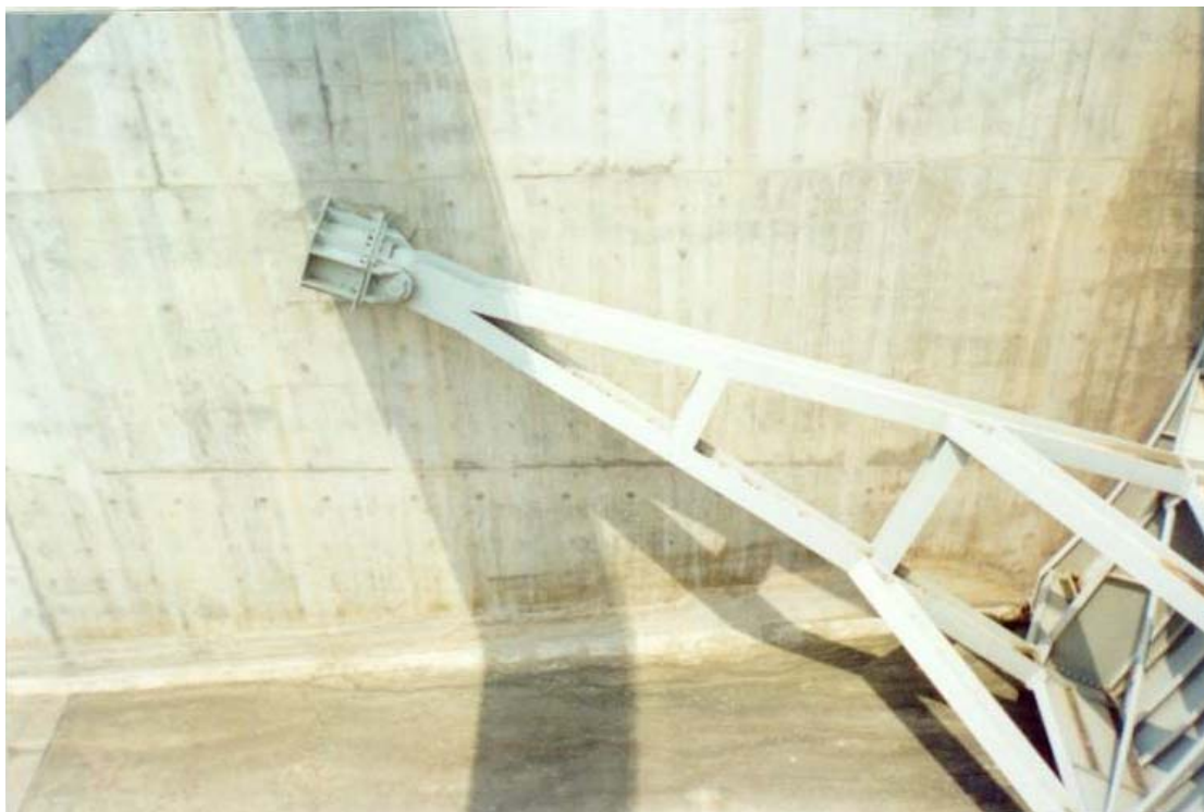
ภาพผนวกที่ 18 ลักษณะของแท่นรับแกนหมุนบานระบาย
