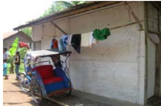
Gambar 6. Kondisi rumah orangtua Vera yang sangat memprihatinkan
