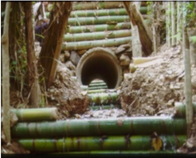
**Figura 6. Empotramiento de tubería para conducir las aguas de la quebrada por debajo de la banca de la carretera. Se observan trinchos vivos escalonados a ambos extremos de la tubería. Febrero 19 de 2003.**
