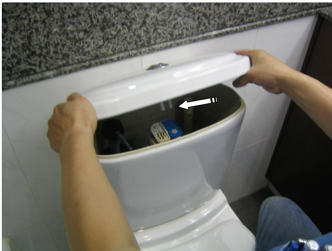
圖 13) 將座廁蓋面合上，並留意接觸位置需吻合。(箭咀示)
