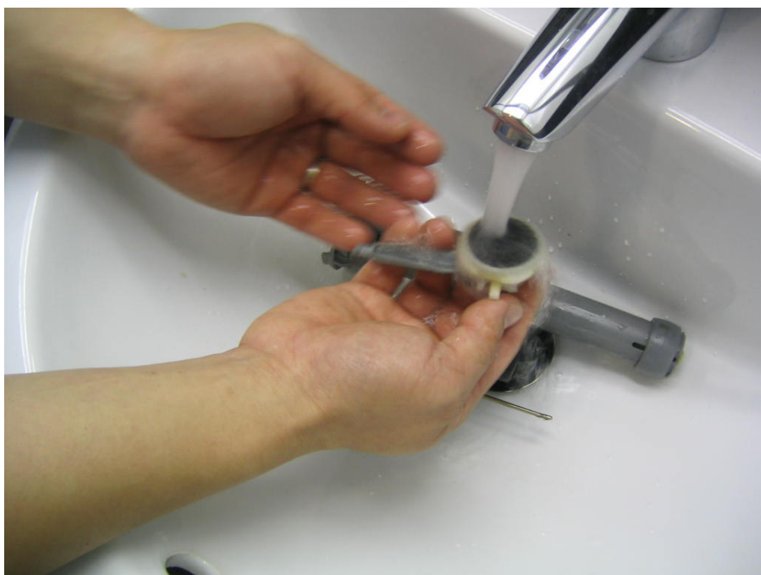
圖 8) 清洗組件，及沖走沉積物。
