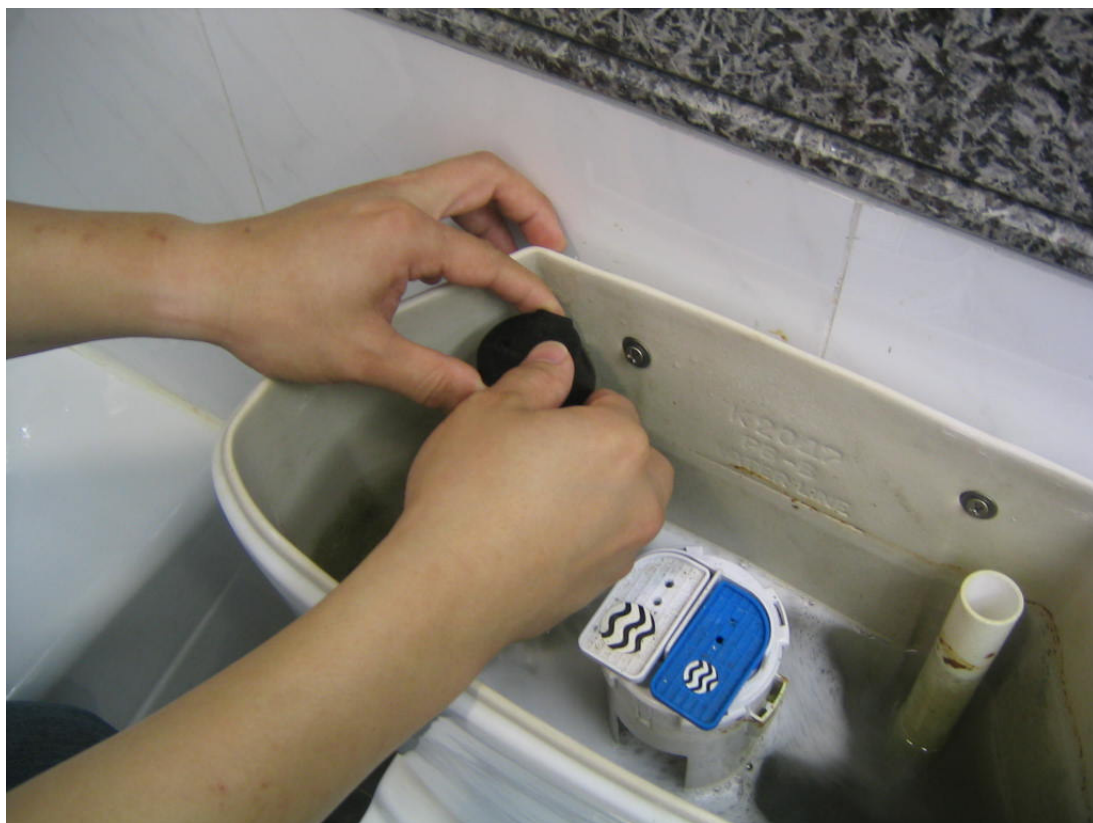
圖 3) 用手輕按上蓋面，以打開浮波蓋(黑色)。
