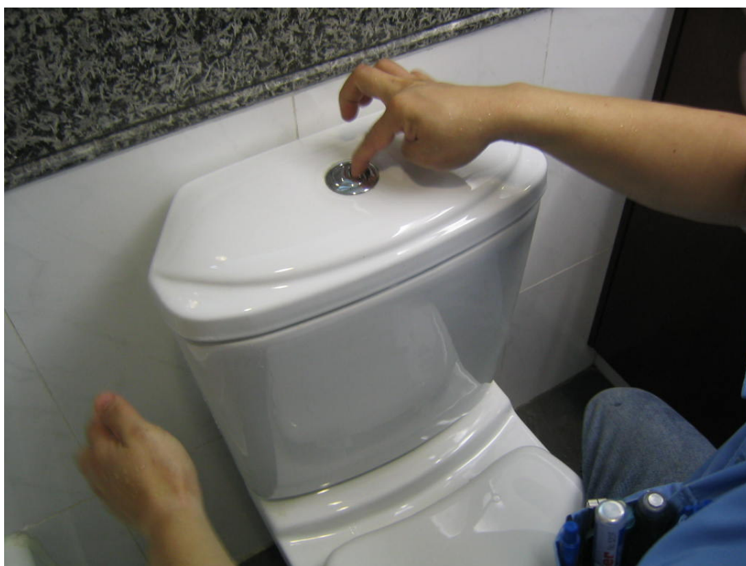
圖 14) 重新按沖廁按鈕以測試水箱運作回覆正常。
