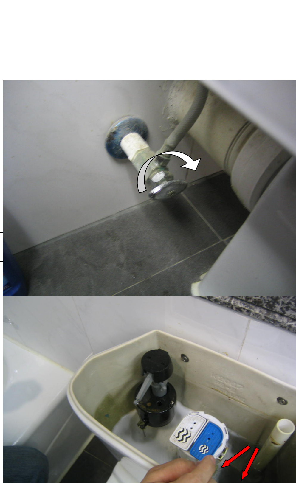
圖 2) 再按沖水掣(箭咀示)，至水箱水位下降。
