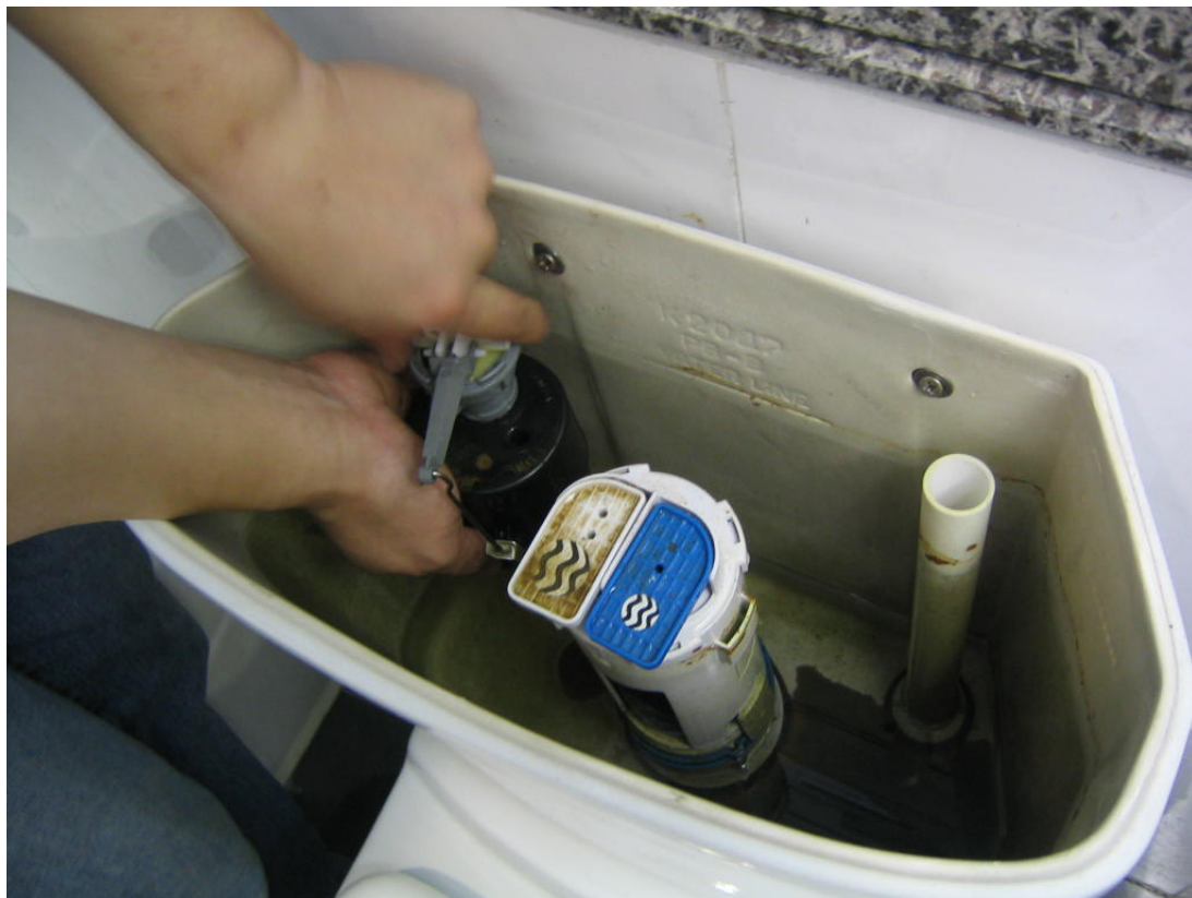
圖 9) 將清洗後之波曲裝配入水箱左側之管軸，及利用圖 5 所提及之圓身伸縮掣鎖定波曲。
