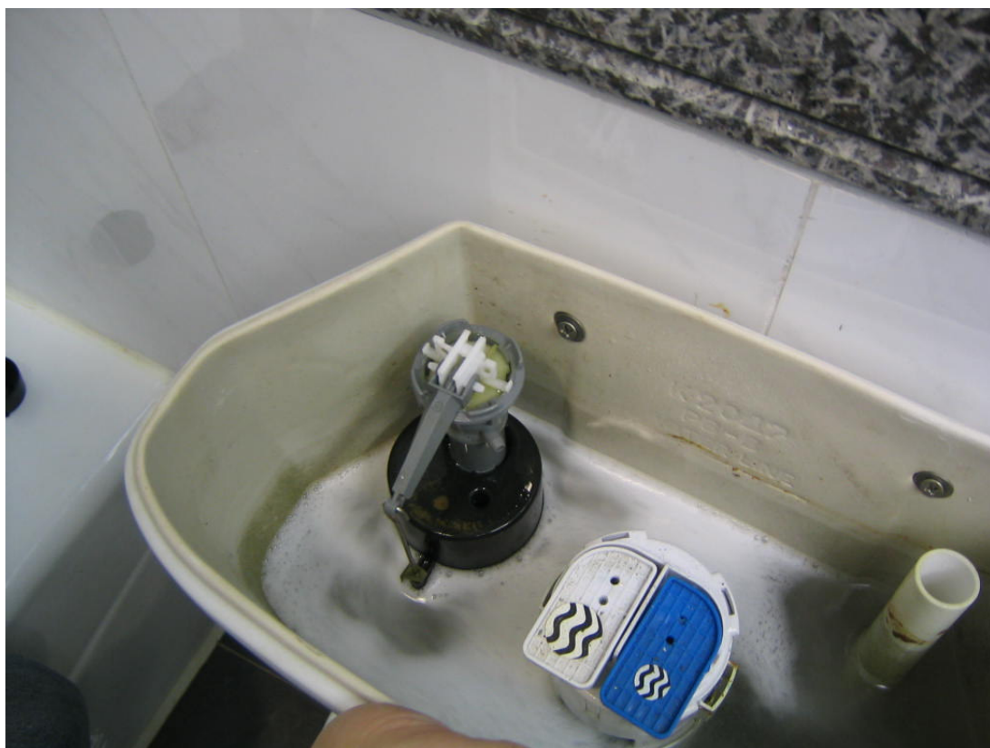
圖 4) 除去黑色上蓋面之波曲掣樣貌。
